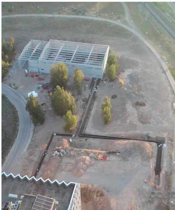
Imagen 4.- Vista aérea central térmica.
