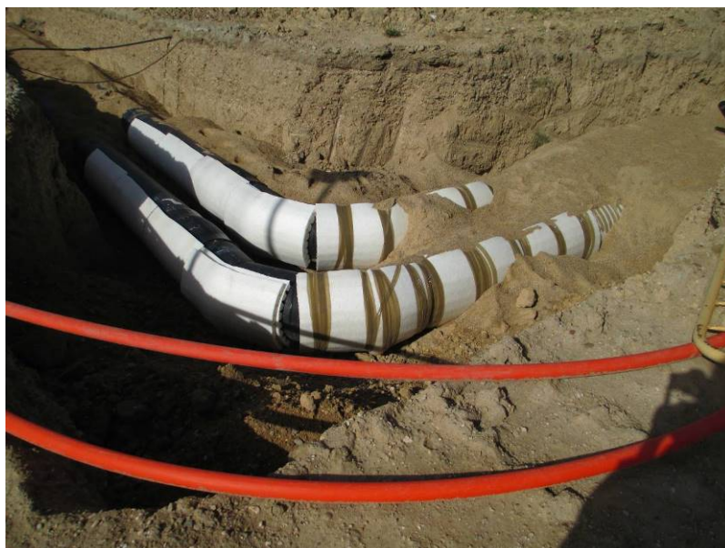
Imagen 17.- Protección de espuma en los codos.
